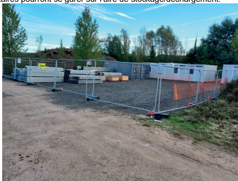
Exemple d'installation de base vie et de zone de stockage
